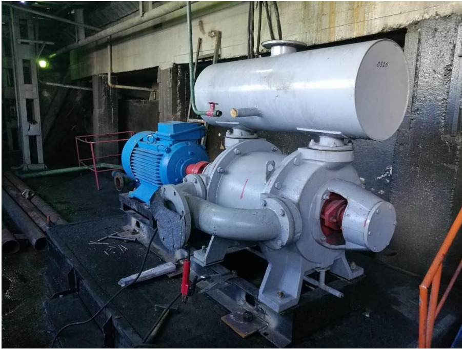
Насос водокольцевой вакуумный ВВН1-25
