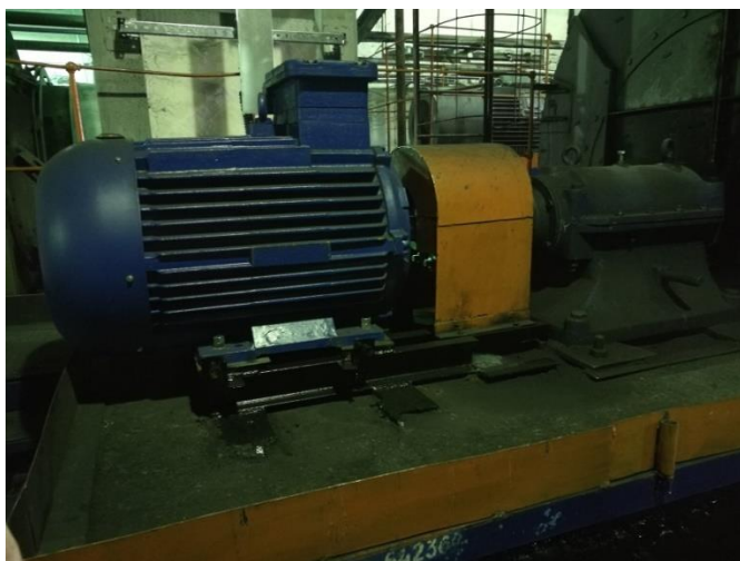
Замена электродвигателя дутьевого вентилятора ВДН-15 КВТС-30 №2
