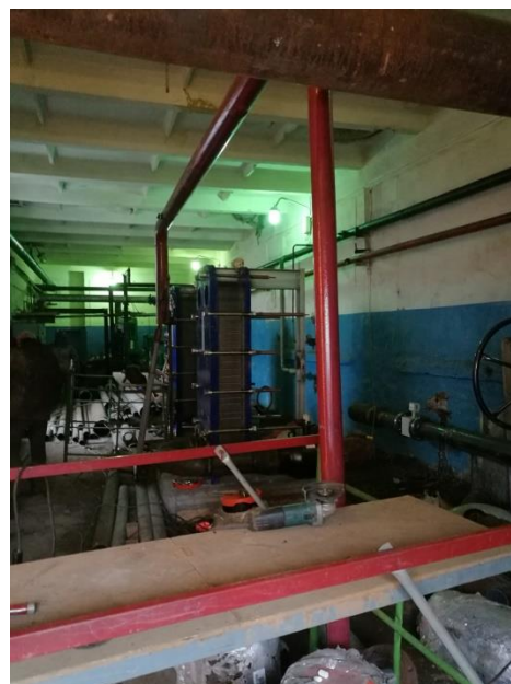
Монтаж теплообменников ЦТП-20
