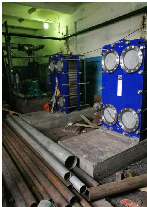
Обвязка насосного и теплообменн ого оборудования ЦТП-20
