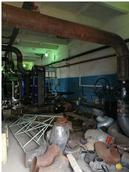
Обвязка насосного и теплообменн ого оборудования ЦТП-20
