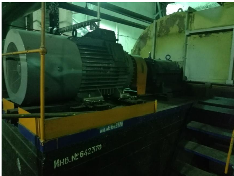
Замена электродвигателя дымососа ДН КВТС-30 №2
