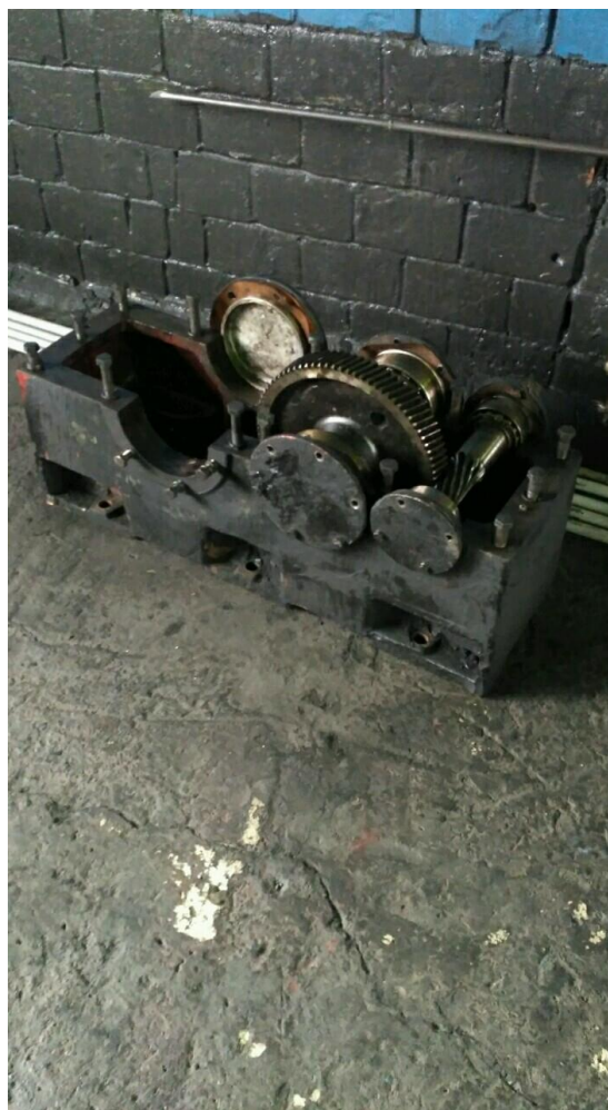
Демонтаж редуктора ленточного конвейера ЛК-8А
