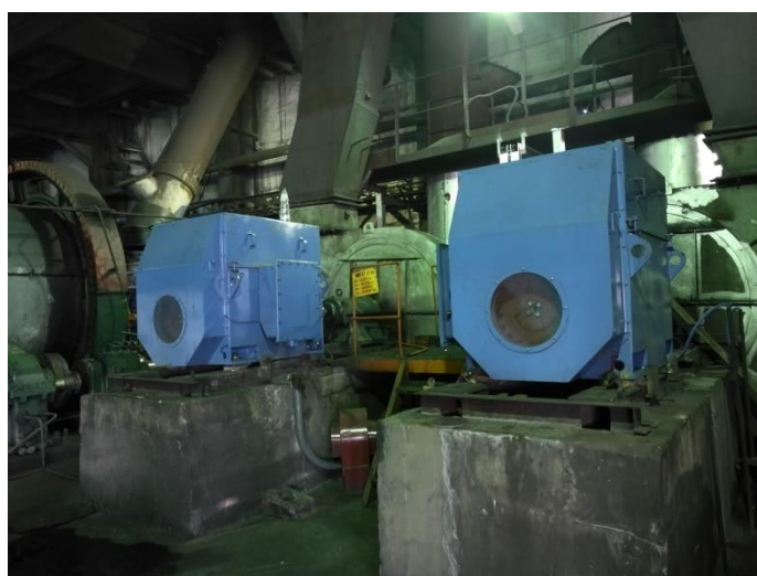
Замена электродвигателей мельничных вентиляторов котла №8
