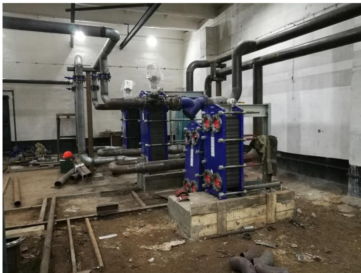
Монтаж теплообменников ЦТП-18
