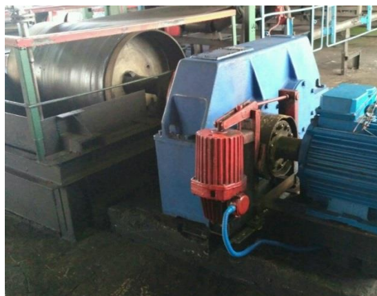
Монтаж редуктора и электродвигателя ЛК-7А
