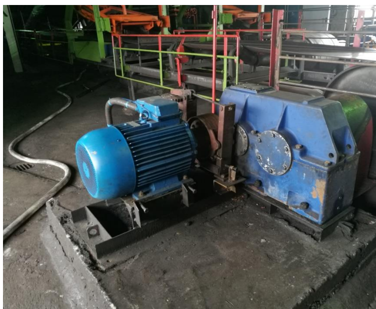
Замена электродвигателей и редукторов ленточных конвейеров 8А и 8Б
