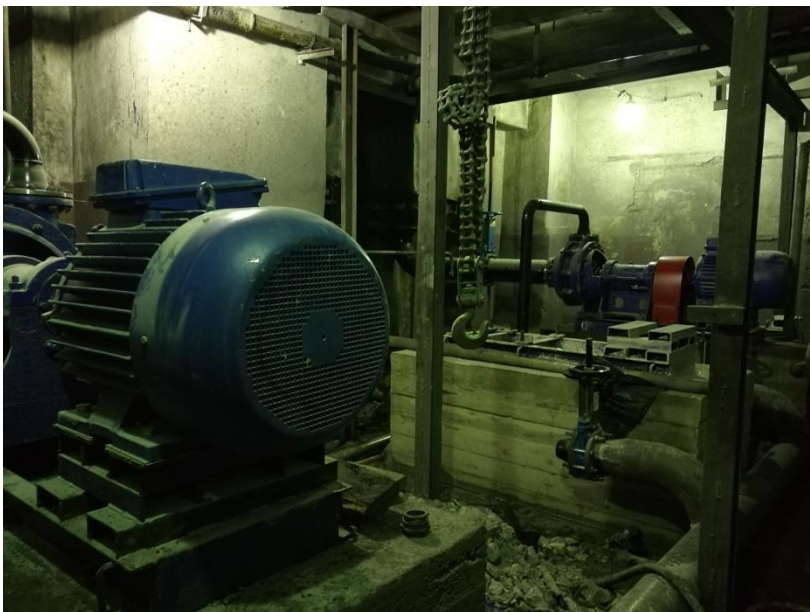
Замена насосов ГРАТ в багерной
