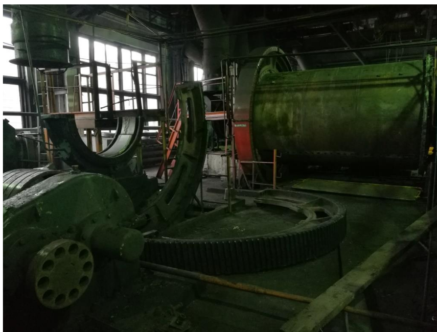
Демонтаж мельницы ШБМ
