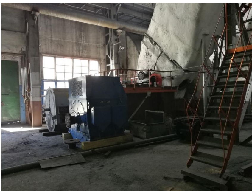
Замена электродвигателя дымососа Котла №7
