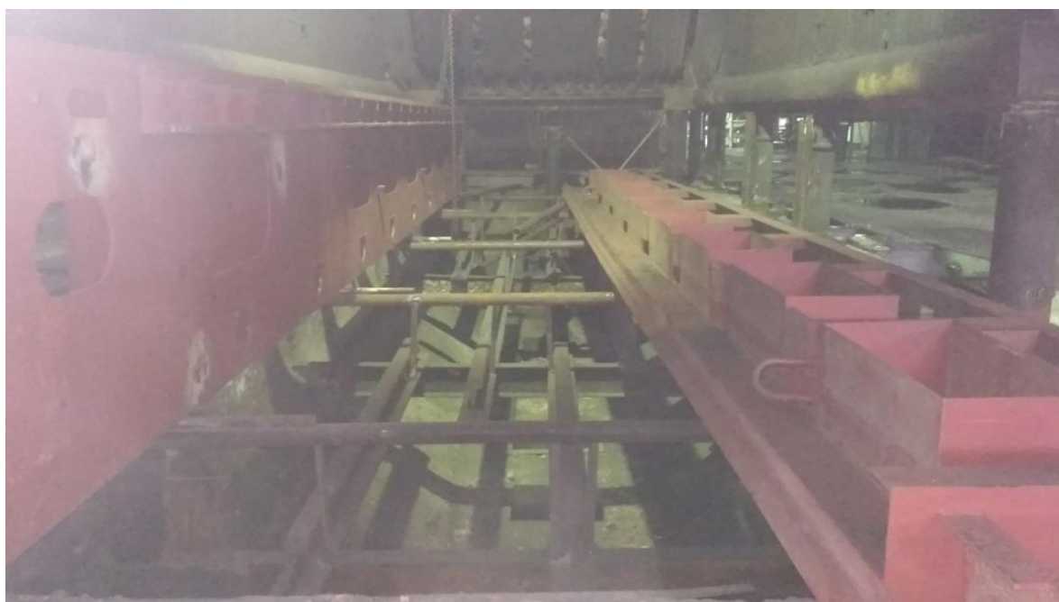
Монтаж щек топки Котла №2 КВТС-30
