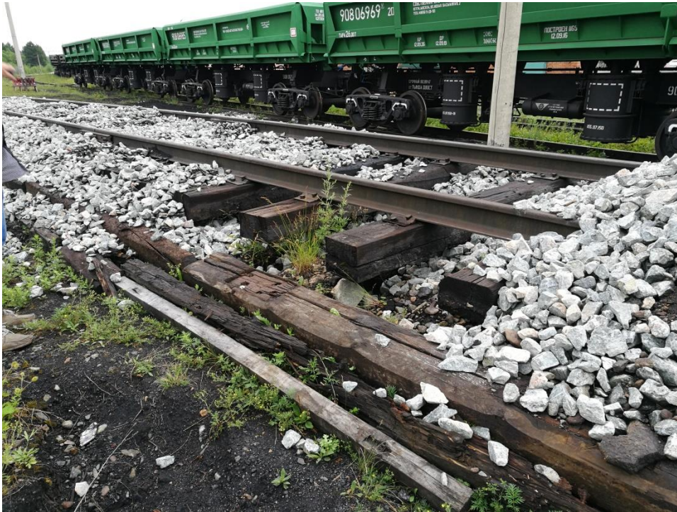
Подготовка площадки для монтажа вагонных весов
