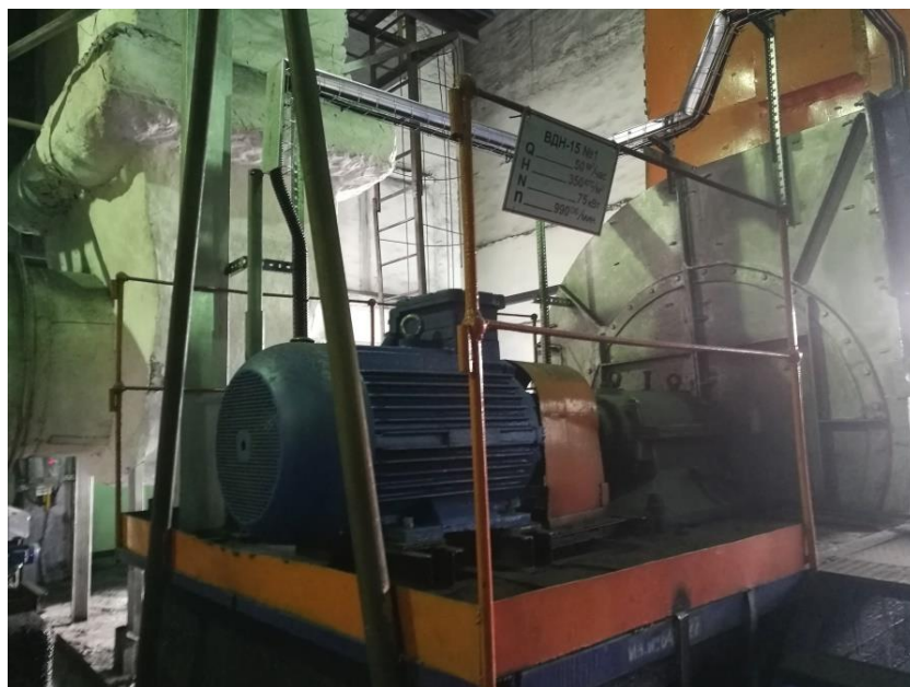
Замена электродвигателя дутьевого вентилятора ВДН-15 КВТС-30 №1
