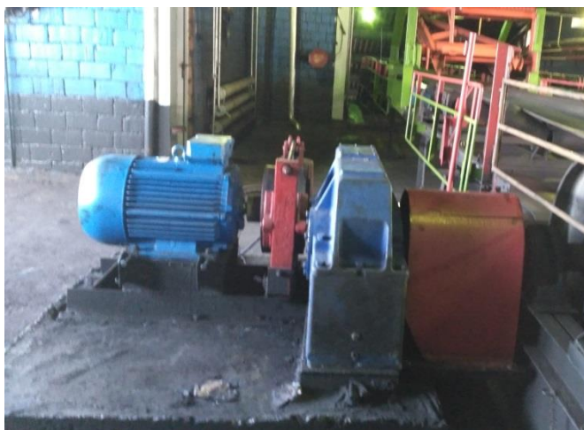
Монтаж редуктора и электродвигателя ЛК-8А
