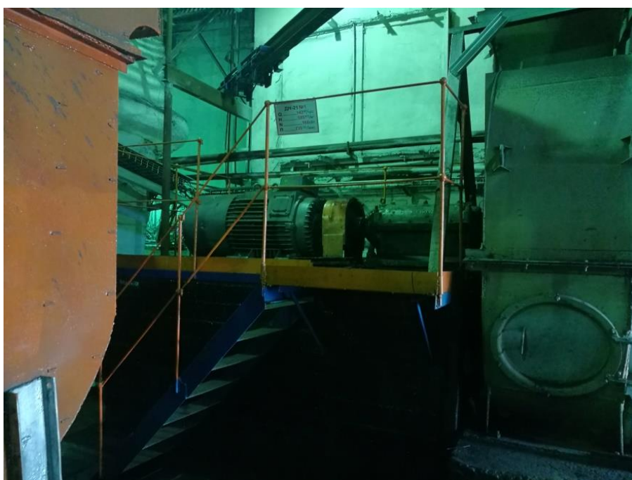
Замена электродвигателя дымососа ДН-21 КВТС-30 №1
