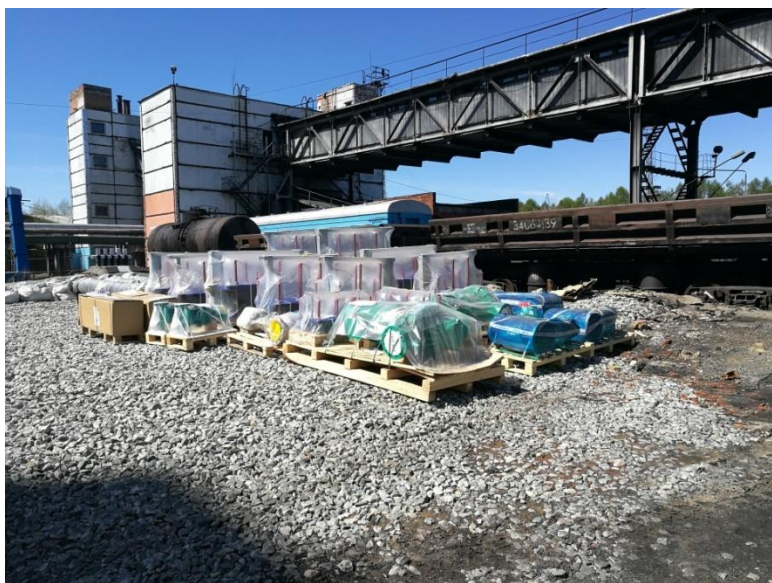
Теплообменное и насосное оборудование для реконструкции ЦТП
