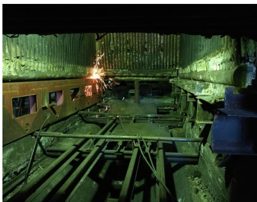
Монтаж топки и ПСКМ котла №4
